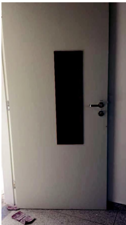
Figura 22 - Acessibilidade: Modelo dos visores das portas das salas de aula Fonte: NENG
