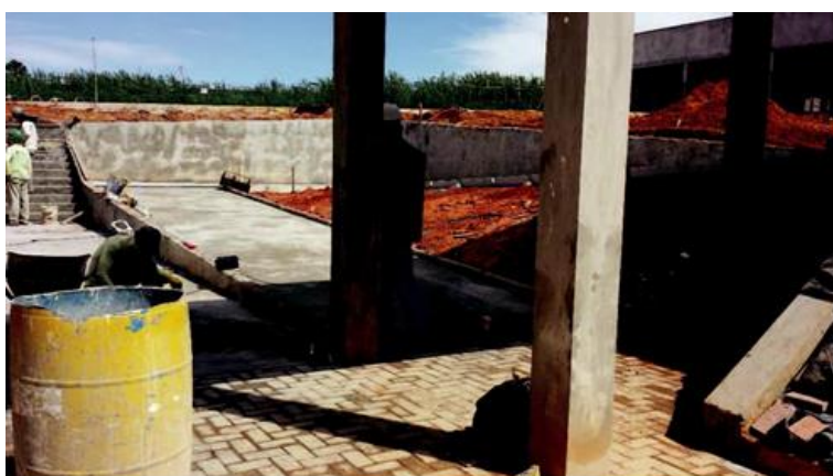
Figura 19 - Acessibilidade: Execução de acessos em rampas (CCEI) Fonte: NENG
