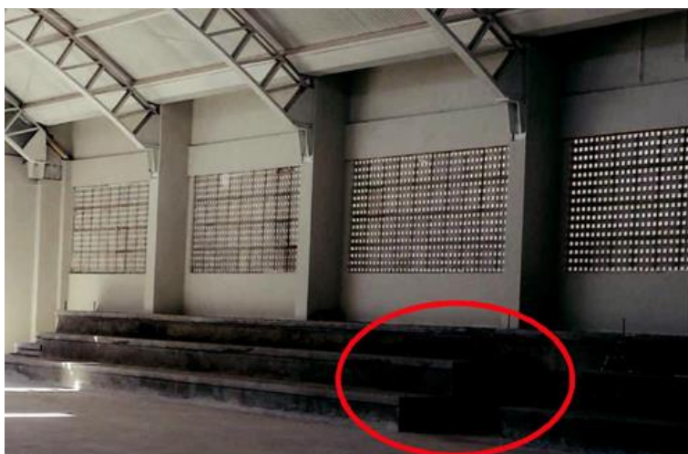
Figura 18 - Acessibilidade: Reserva de espaço para P.N.E. no bloco do ginásio Fonte: NENG
